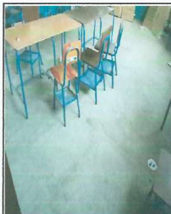
Foto 3: Mejoramiento y cambio de piso
