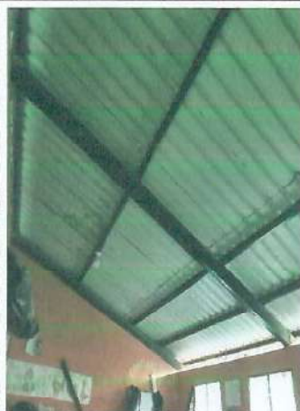
Foto1: Cambio de laminas del aula de parvulos
